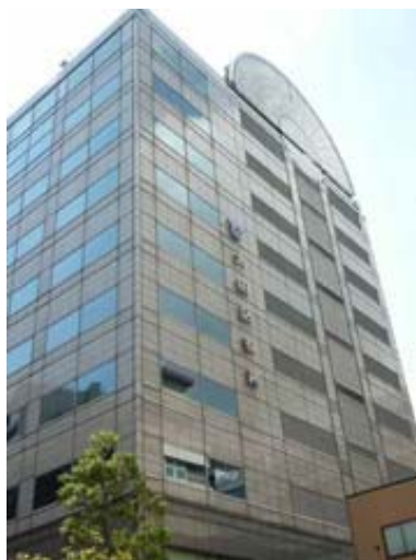
大田区役所全景
