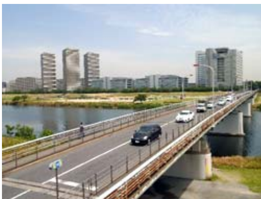
川崎方向から見る矢口地区
