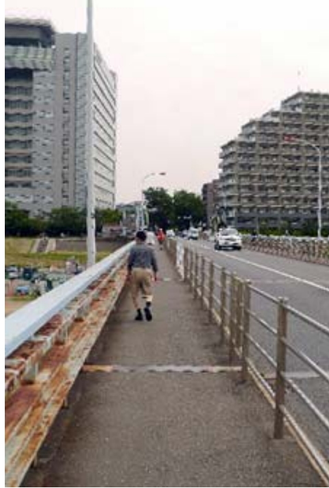
現在のガス橋
