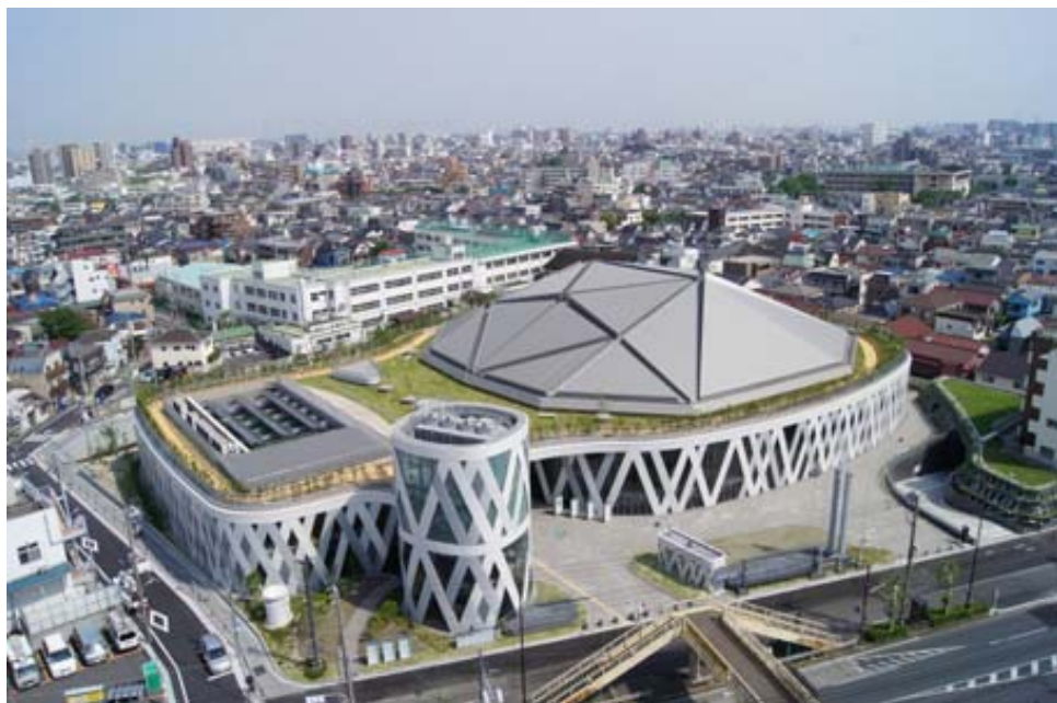
大田区総合体育館
